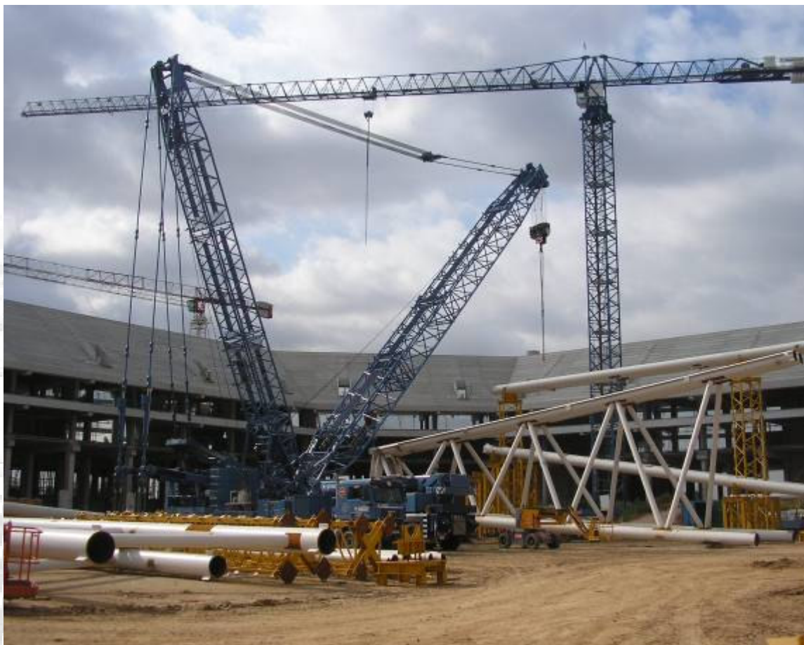
Vistes generals d'obra. Treballs de muntatge de cerchas principals d'acer en obra.
