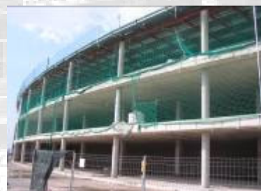
Vista de les xarxes verticals de la façana interiors a l'estructura durant els treballs de muntatge exterior de la façana.
