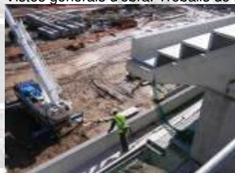
Vistes generals d'obra. Treballs de muntatge de graderies i portagraderies en obra.
