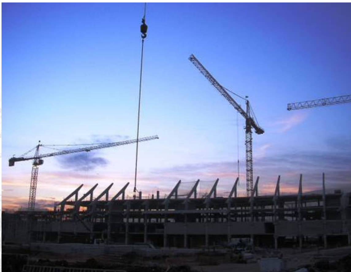
Vista general de obra. Proteccions col·lectives de l'obra en fase de muntatge de graderies (portagraderies i graderies).
