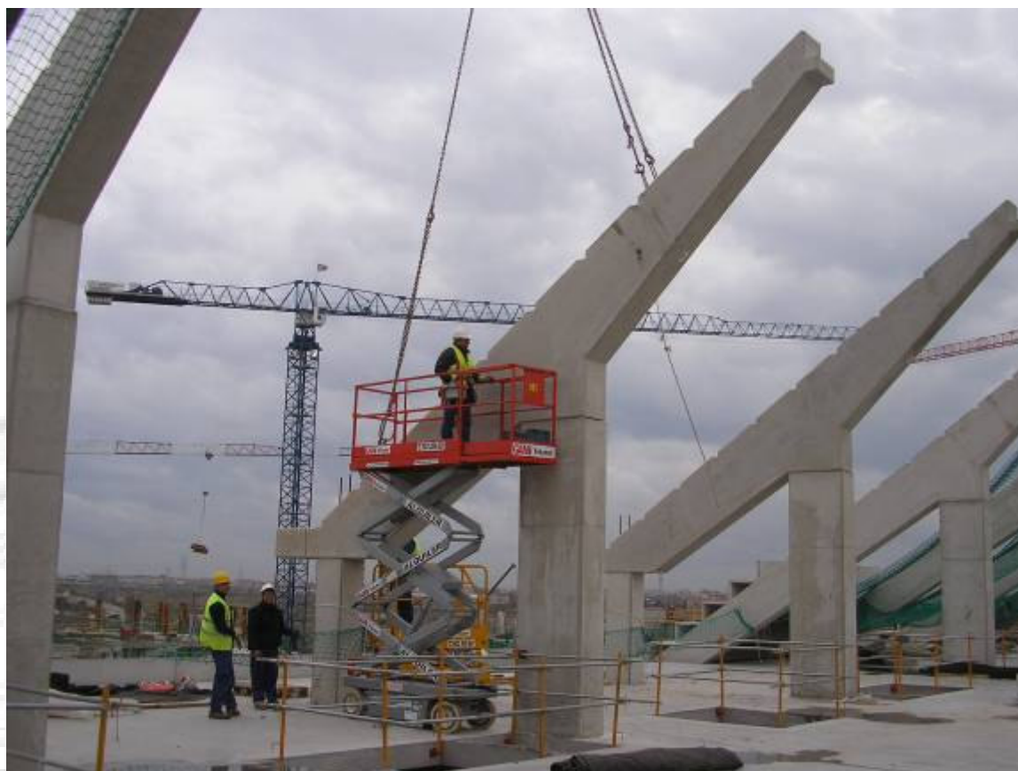
Vista de les els treballs de muntatge de graderies utilitzant cistelles autopropulsades i un procediment de comunicació i senyalització, amb el gruista, en l'izado i posada en obra de portagraderies.
