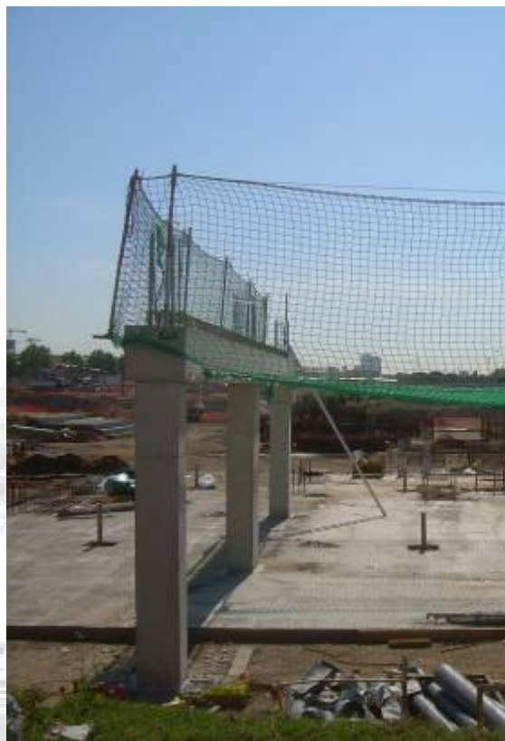
Vista de perímetre de seguretat en muntatge de llores amb xarxes de seguretat tipus tennis.
