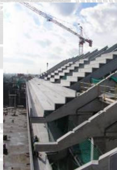
Vista de les els treballs de muntatge de graderies utilitzant cistelles autopropulsades i un procediment de comunicació i senyalització, amb el gruista, en l'izado i posada en obra de portagraderies.
