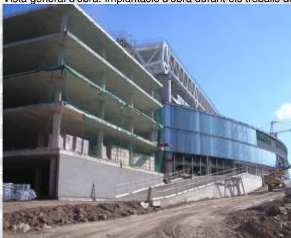
Vista general d'obra. Treballs de muntatge de façana de l'estadi.
