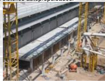
Vista general d'obra. Implantació d'obra durant els treballs de muntatge de coberta de l'estadi.
