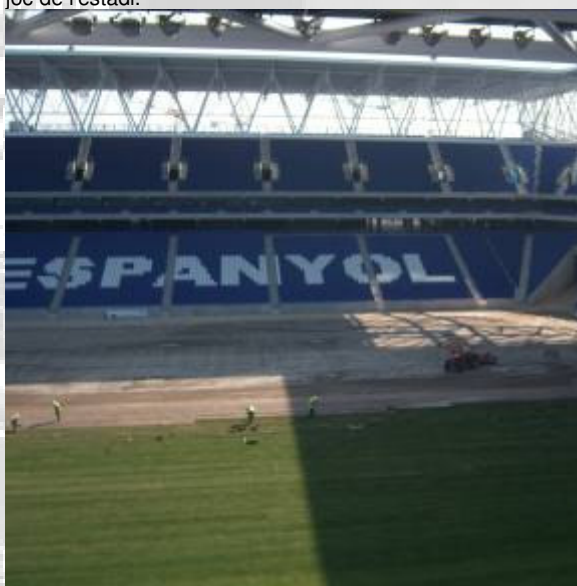
Vista dels treballs de col·locació de rotlles de pans de gespa en tot el terreny de joc de l'estadi.
