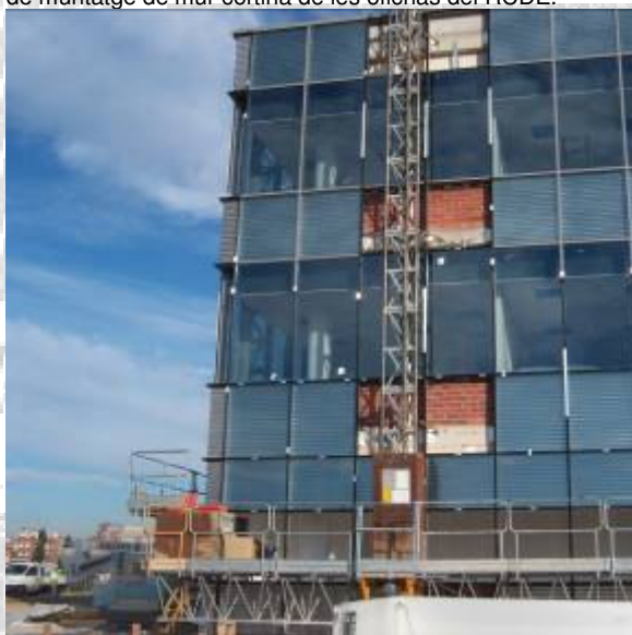
Vista general dels treballs de mur cortina de les oficines del RCDE. Muntatge de vidres de remat exterior de façana.
