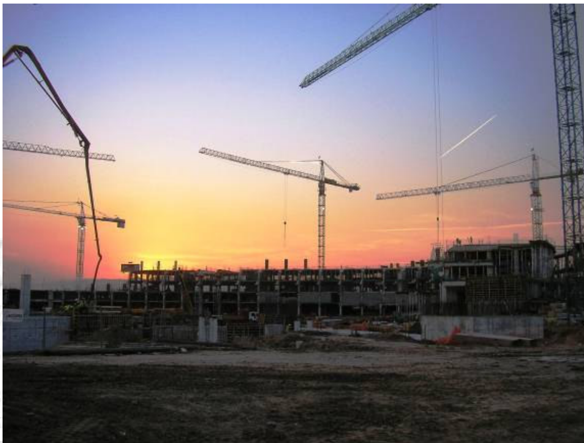
Vista general de les proteccions col·lectives de l'obra en fase d'execució d'estructura de formigó in situ.
