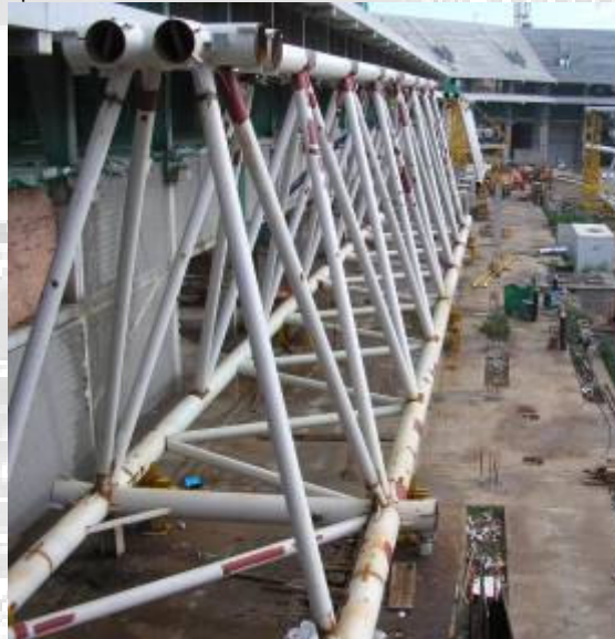
Vista dels treballs d'unió d'encavallades a l'obra.
