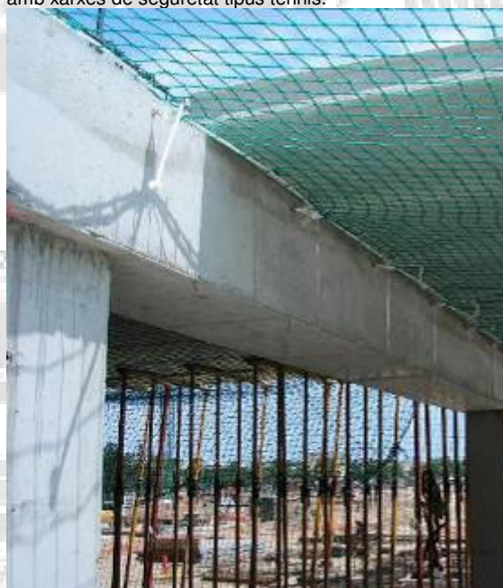
Protecció de llores prefabricades amb xarxes de seguretat horitzontals.
