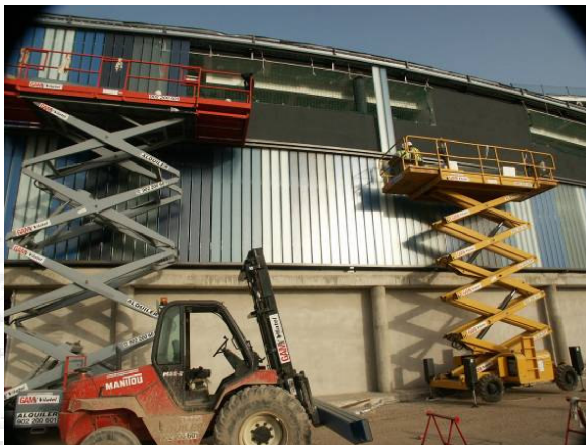
Vistes generals de la façana de l'estadi. Procediment de muntatge de façana de vidre utilitzant plataformes elevadores autopropulsades.
