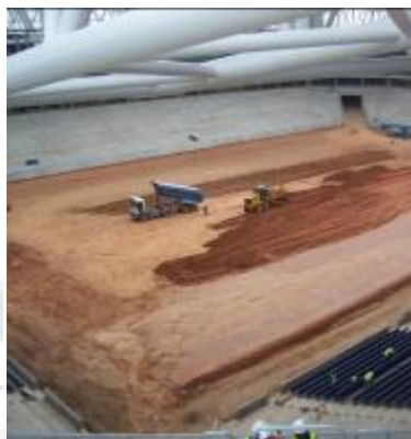
Vista dels treballs d'estesa de terres amb mototrailla en terreny de joc.
