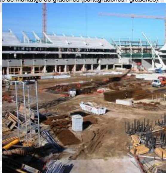
Vista general de obra. Proteccions col·lectives de l'obra en fase de muntatge de graderies (portagraderies i graderies).
