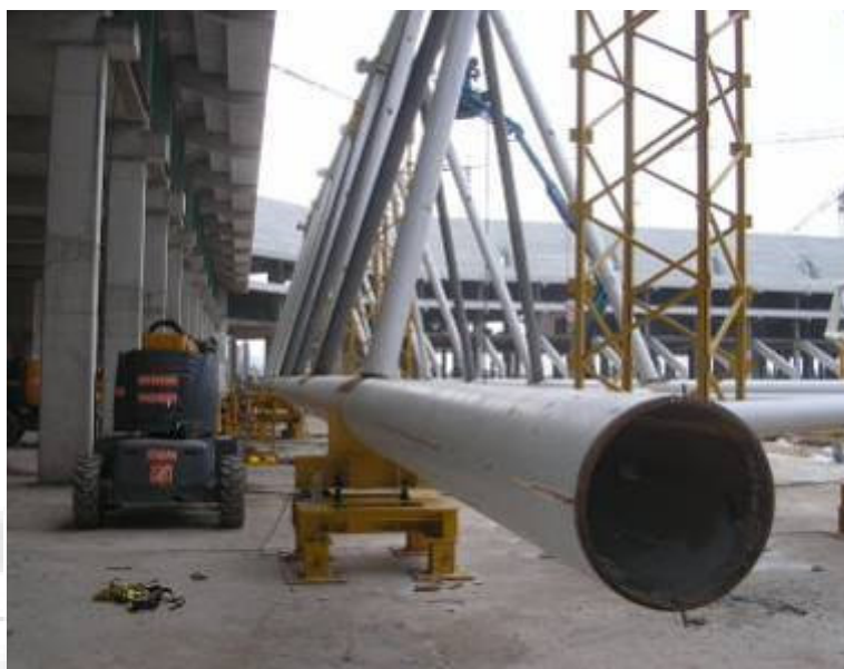
Vistes generals de l'obra. Treballs de muntatge de encavallades de l'estructura de la coberta de l'estadi (soldadura d'unions de encavallades, muntatge de encavallades secundàries, execució d'unions a suports d'estructura de formigó, etc ...).
