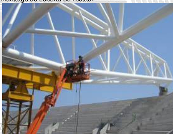
Vista els treballs de soldadura d'unions de encavallades en alçada utilitzant cistelles autopropulsades.
