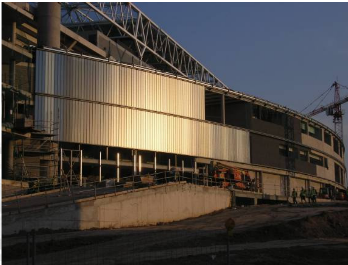
Vista general d'obra. Implantació d'obra durant els treballs de muntatge de façana de l'estadi.
