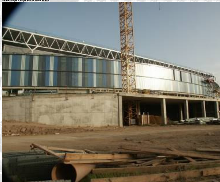
Vistes generals de la façana de l'estadi. Procediment de muntatge de façana de vidre utilitzant plataformes elevadores autopropulsades.
