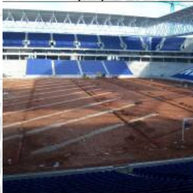
Vista dels treballs de rebliment de grava sobre tubs drenants i posterior capa de filtració de grava en tot el terreny de joc de l'estadi.
