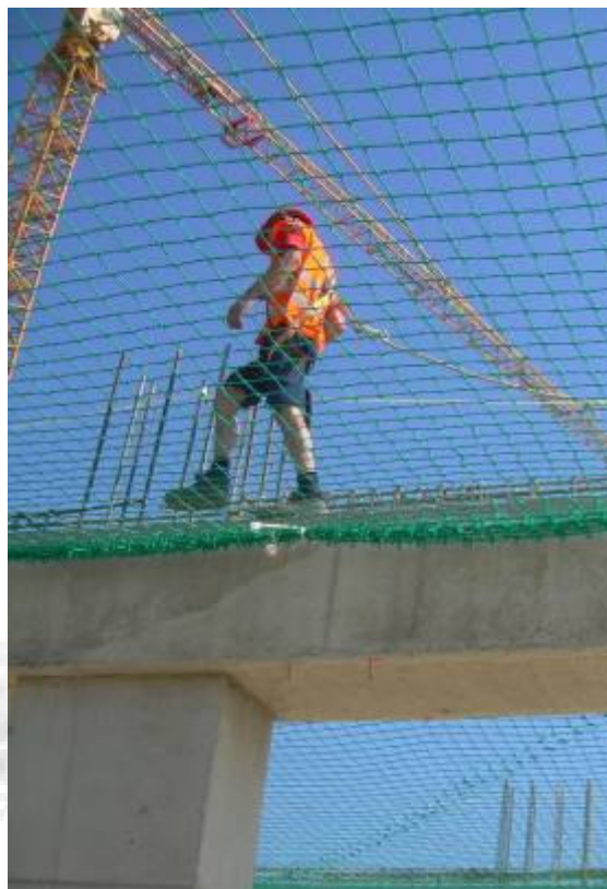
Vista de les els treballs de muntatge de graderies utilitzant arnès de seguretat ancorat a línia de vida i xarxa horitzontal de seguretat sota portagrades.
