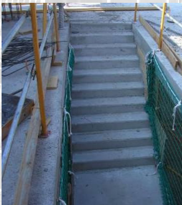
Protecció de zancas d'escala amb xarxes de seguretat verticals.
