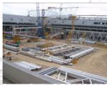
Vistes generals de l'obra. Treballs de muntatge de encavallades de l'estructura de la coberta de l'estadi (soldadura d'unions de encavallades, muntatge de encavallades secundàries, execució d'unions a suports d'estructura de formigó, etc ...).
