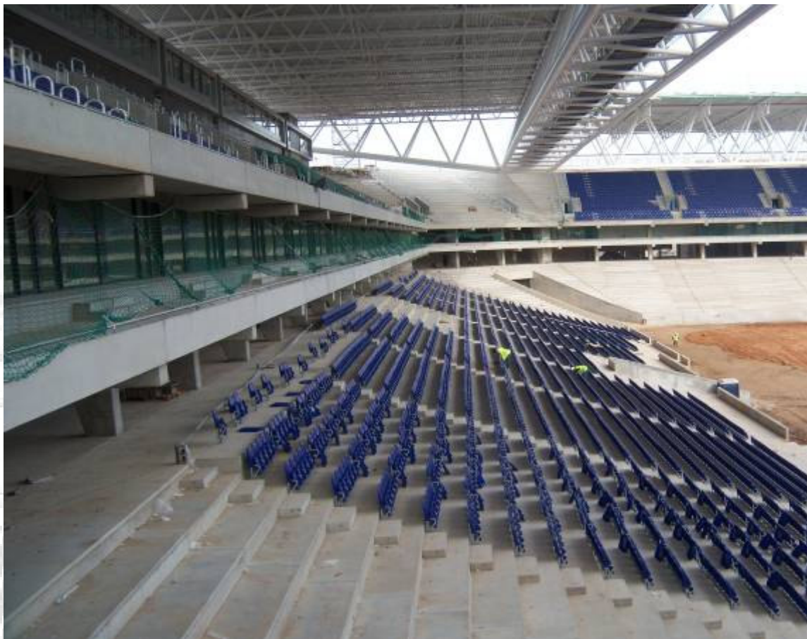
Vista dels treballs de muntatge de butaques a l'obra en grada baixa de l'estadi.
