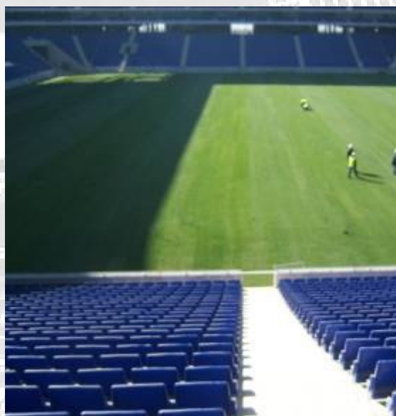
Vista dels treballs de compactació i rematada de la gespa a tot el terreny de joc de l'estadi.
