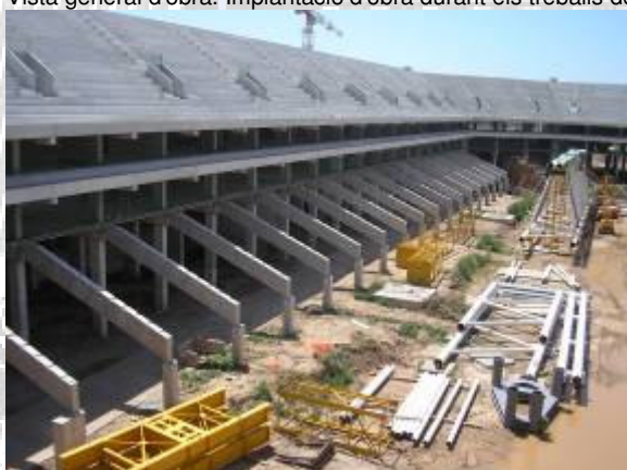
Vista general d'obra. Implantació d'obra durant els treballs de muntatge de coberta de l'estadi.
