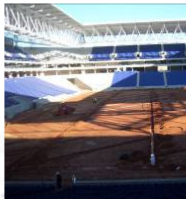
Vista dels treballs d'execució de rases per al drenatge en l'estadi.
