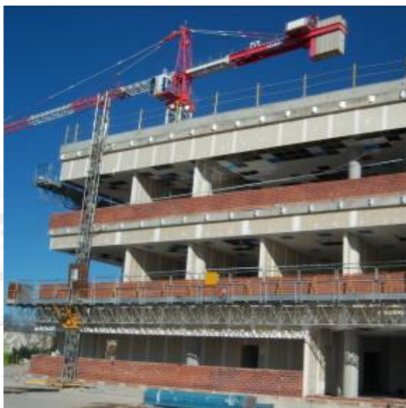
Vista dels bastida de cremallera disposats per als treballs de muntatge de mur cortina de les oficinas del RCDE.
