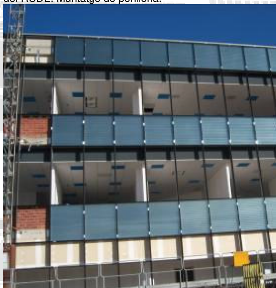
Vista general dels treballs de mur cortina de les oficines del RCDE. Muntatge de xapa de fons en peto cecs de forjats.
