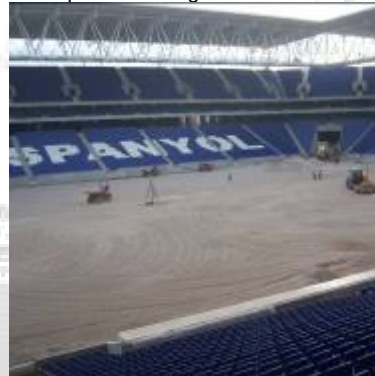
Vista dels treballs de rebliment de grava sobre tubs drenants i posterior capa de filtració de grava en tot el terreny de joc de l'estadi.
