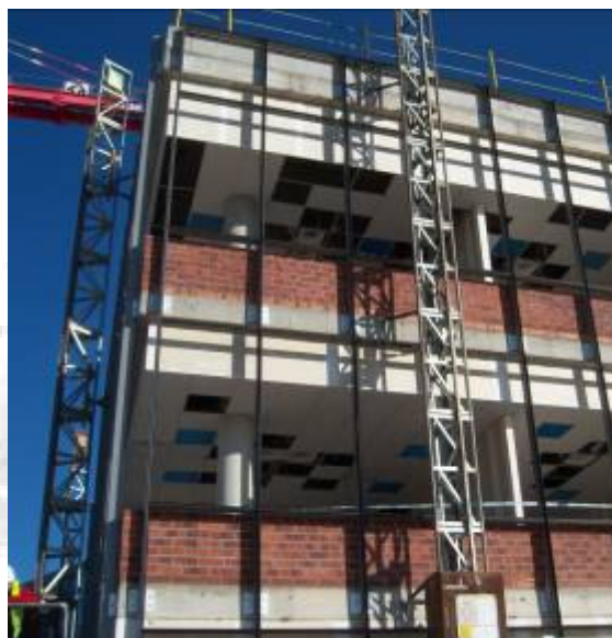
Vista general dels treballs de mur cortina de les oficines del RCDE. Muntatge de perfil·leria.
