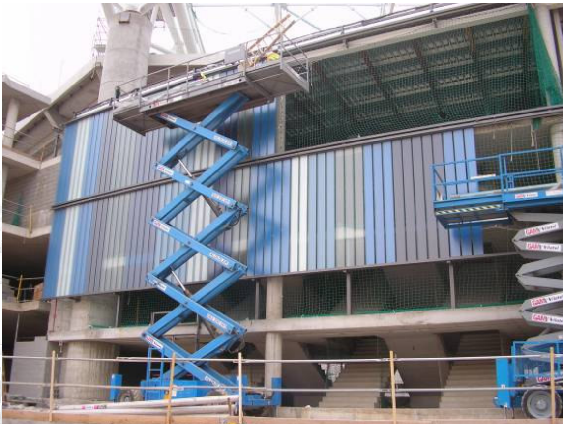
Vista dels treballs de muntatge de vidres tipus U-Glass en façana perimetral de l'estadi.
