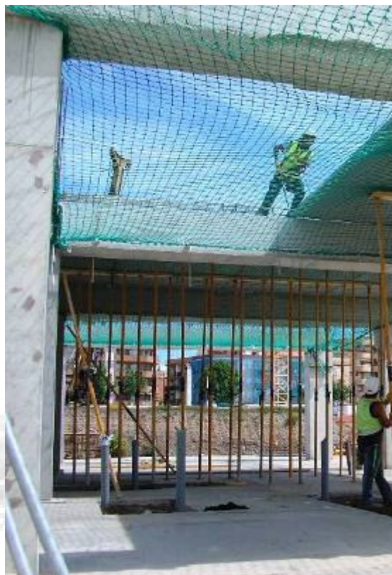
Vista del muntatge de lloses de forjats de l'estructura amb arnes de seguretat, línia de vida i les xarxes horitzontals de protecció.
