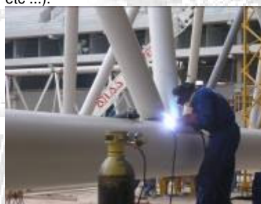
Vistes generals de l'obra. Treballs de muntatge de encavallades de l'estructura de la coberta de l'estadi (soldadura d'unions de encavallades, muntatge de encavallades secundàries, execució d'unions a suports d'estructura de formigó, etc ...).
