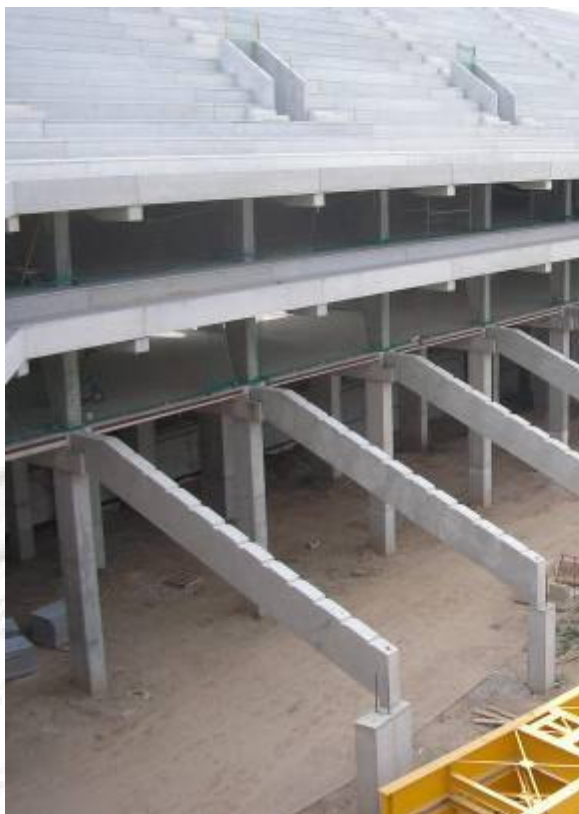
Vista de les xarxes verticals de protecció en forjats de l'estadi per a impedir l'accés a la zona de muntatge de graderies.
