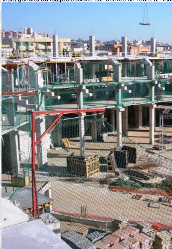
Vista general de obra. Proteccions col·lectives de l'obra en fase d'execució d'estructura de formigó in situ.
