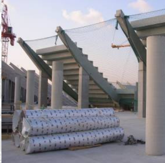
Vista de la xarxa de protecció durant la fase de muntatge de graderies (portagraderies i graderies).
