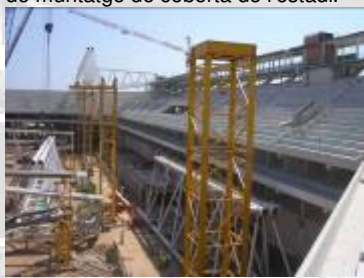
Vista de les torres de fitació de les encavallades principals de la coberta.
