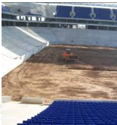
Vista dels treballs de farciment de terres en terreny de joc.
