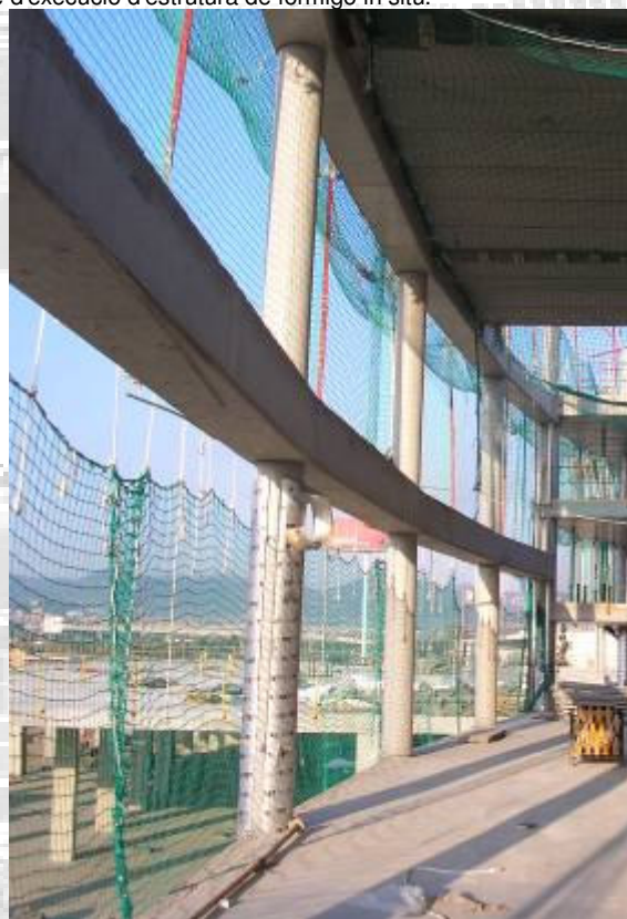
Vista general de obra. Proteccions col·lectives de l'obra en fase d'execució d'estructura de formigó in situ.
