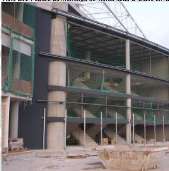
Vista de les proteccions interiors de forjats de l'estadi mitjançant xarxa vertical ancorada a forjats de formigó durant els treballs de muntatge de façana perimetral de vidre.
