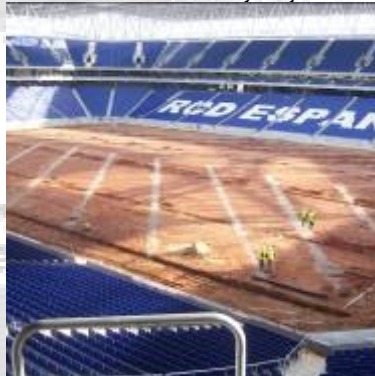
Vista dels treballs de rebliment de grava sobre tubs drenants i posterior capa de filtració de grava en tot el terreny de joc de l'estadi.
