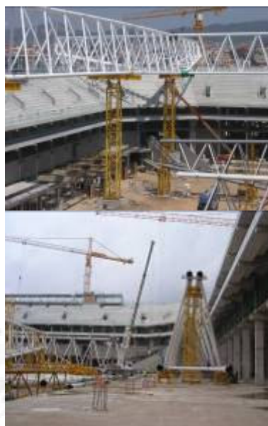
Vistes generals de l'obra. Treballs de muntatge de encavallades de l'estructura de la coberta de l'estadi (soldadura d'unions de encavallades, muntatge de encavallades secundàries, execució d'unions a suports d'estructura de formigó, etc ...).
