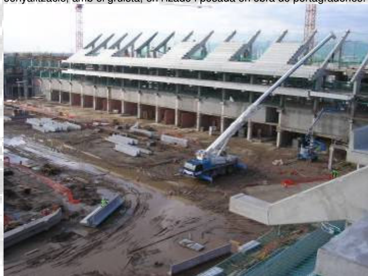
Vistes generals d'obra. Treballs de muntatge de graderies i portagraderies en obra.
