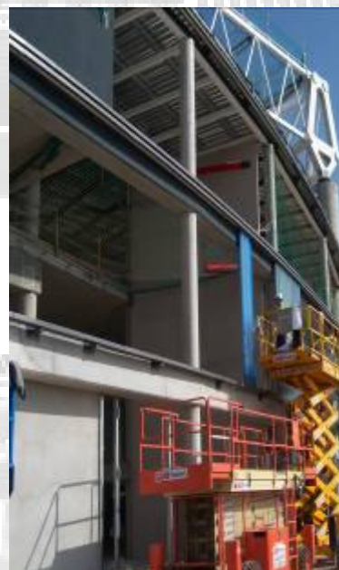
Vistes generals de la façana de l'estadi. Procediment de muntatge de façana de vidre utilitzant plataformes elevadores autopropulsades.
