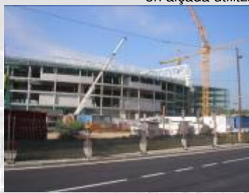
Vista general d'obra.
