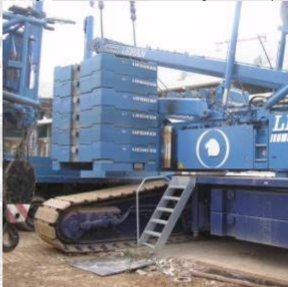
Vista de la grua de gelosia utilitzada en el muntatge de la coberta.
