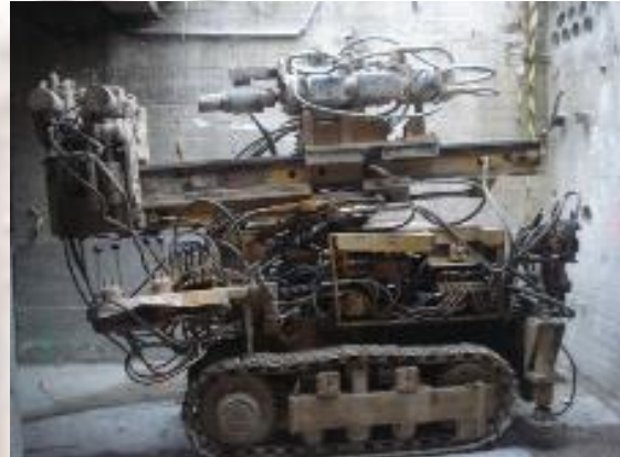
Vista general dels treballs d'execució de micropilotatge en soterrani -1 de l'edifici cel·les.
