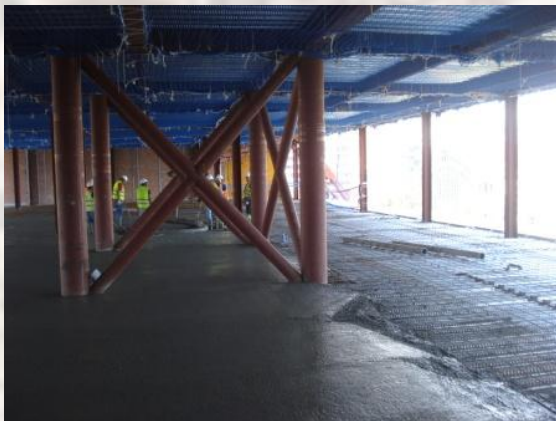
Vista dels treballs de formigonat de sostres a la zona Nàpols
