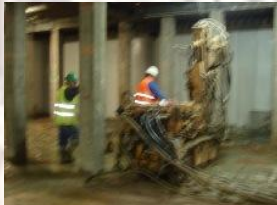
La maquinària utilitzada per a l'execució de micropilots en aquesta zona d'obra amb risc d'alta tensió es connecten a terra segons les prescripcions indicades per la propietat.
