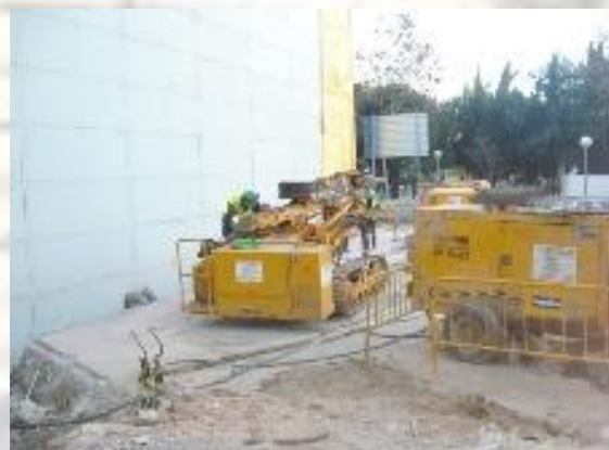
La maquinària utilitzada per a l'execució de micropilots en aquesta zona d'obra amb risc d'alta tensió es connecten a terra segons les prescripcions indicades per la propietat.
