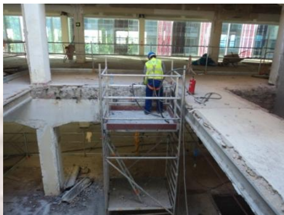
Vista general dels treballs, proteccions col·lectives i proteccions individuals durant els treballs de demolició en plantes de l'Edifici Almogàvers.
