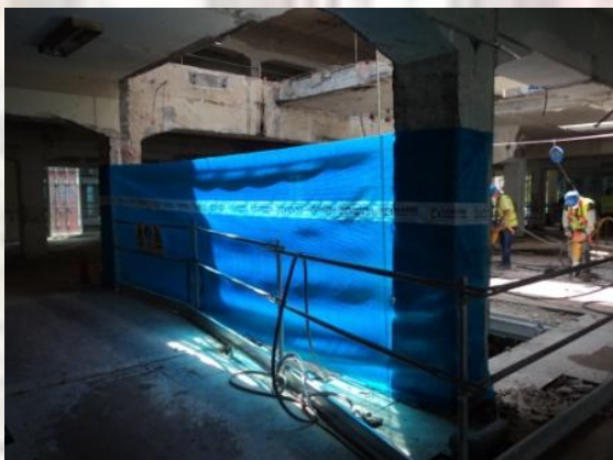
Vista de les línes de vida disposades per al treball de picat manual de forjats de planta en Ed Almogàvers.
