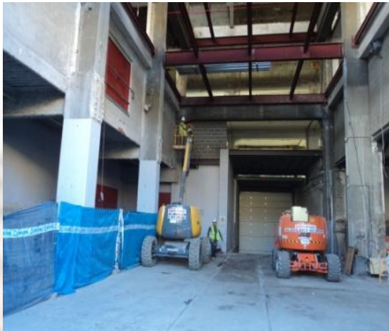
Vista de les dels treballs de muntatge d'estructura d'acer per continuïtat de forjats en zona del moll de càrrega de l'obra zona Almogàvers.
