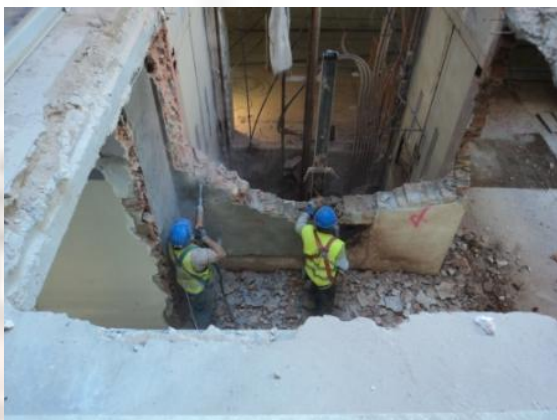
Vista general dels treballs, proteccions col·lectives i proteccions individuals durant els treballs de demolició en plantes de l'Edifici Almogàvers.
