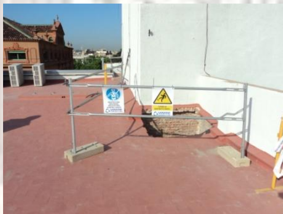
vista de les proteccions col·lectives mitjançant barana rígida de seguretat en buits de forjat del Ed Almogàvers.
