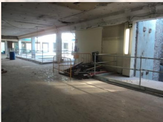
vista de les proteccions col·lectives mitjançant barana rígida de seguretat en buits de forjat del Ed Almogàvers.
