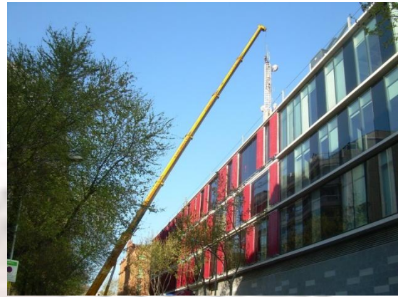
Vista de la grua autopropulsada de l'obra utilitzada per desmuntatge de l'antena de comunicacions.
