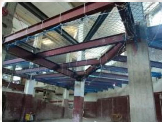
Vista general de l'obra i proteccions col·lectives realitzades mitjançant xarxa de seguretat en fase d'estructura d'acer en zona Almogàvers.
