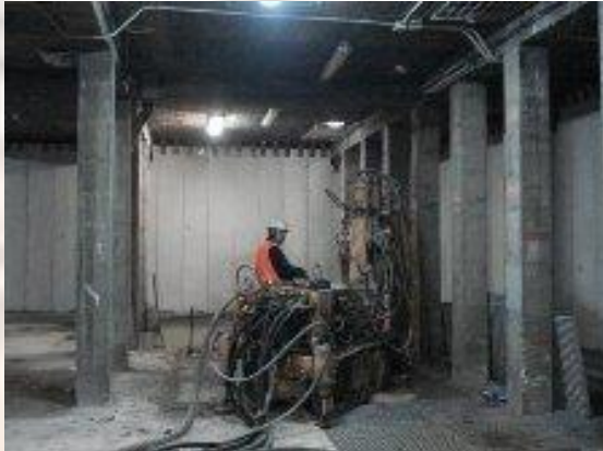
Vista general dels treballs d'execució de micropilotatge en soterrani -1 de l'edifici cel·les.
