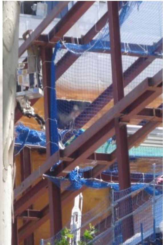
Vista general de l'obra i proteccions col·lectives realitzades mitjançant xarxa de seguretat en fase d'estructura d'acer en zona Nàpols.
