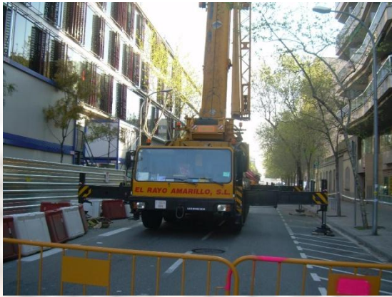
Vista de la grua autopropulsada de l'obra utilitzada per desmuntatge de l'antena de comunicacions.
