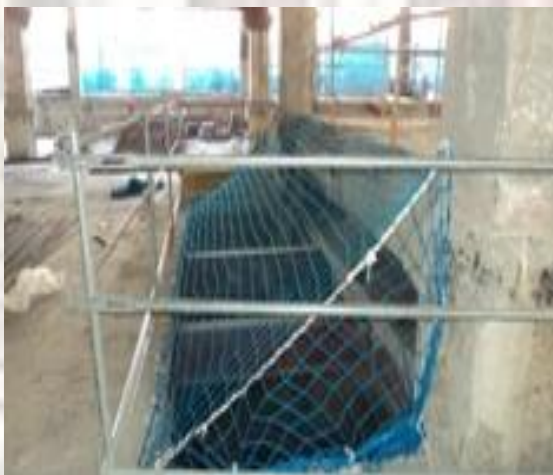
Vista de les proteccions col·lectives de buits de forjat en zona Almogàvers.
