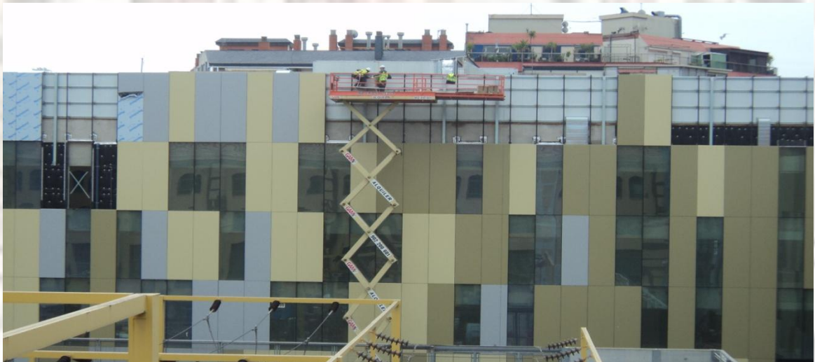
Els treballs en façanes interiors de l'edifici almogàvers es va realitzar plataformes autopropulsades. Els panells composite es conformava en un taller d'obra disposa la planta baixa de l'edifici a la cantonada entre carrer Almogàvers i carrer Roger de Flor.
