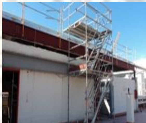
Vista dels accessos a zona de lloses en Badalot d'escala central mitjançant bastida tubular en zona Almogàvers.
