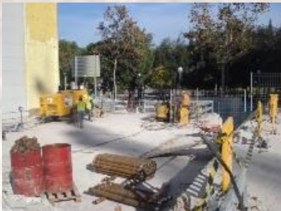
La maquinària utilitzada per a l'execució de micropilots en aquesta zona d'obra amb risc d'alta tensió es connecten a terra segons les prescripcions indicades per la propietat.
