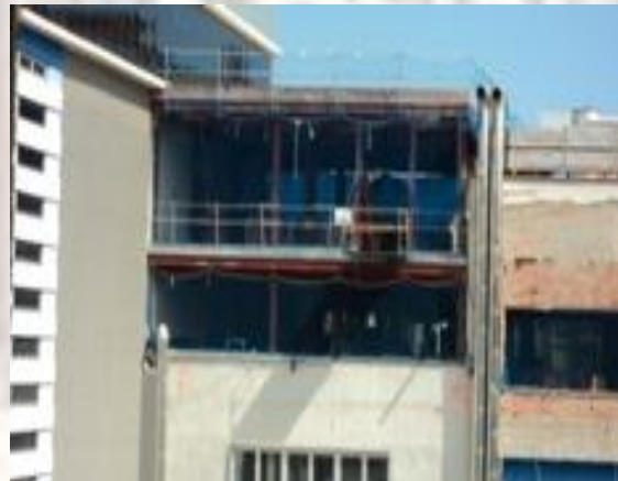
Vista de la zona d'execució de remunta d'estructura sobre la zona de control de la Subestació en zona Almogàvers.
