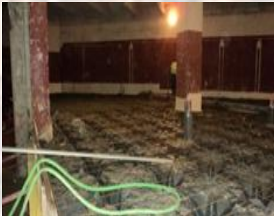
Execució de llosa de formigó en zona soterrani -1 de l'edifici Almogàvers.
